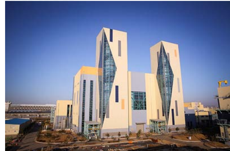
834 MW-GuD-Kraftwerk ANSAN (Südkorea) Werkbild Siemens (2019)
