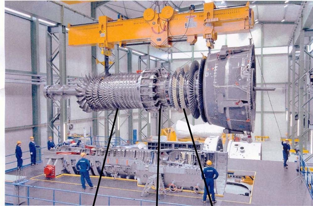
Siemens-Mitarbeiter bei der Montage der SGT5-8000H
